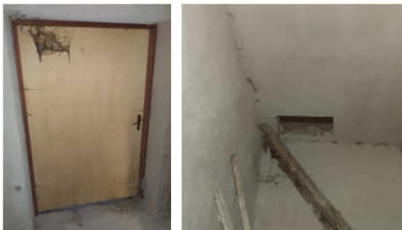
Immagini 5 e 6 – Porta di ingresso del piano seminterrato e botola di collegamento con il piano sovrastante
